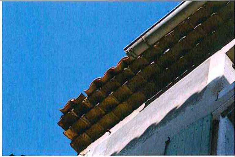
Les chéneaux sont cassés tant celui situé au niveau de la toiture que la descente située en façade sur le côté gauche.
