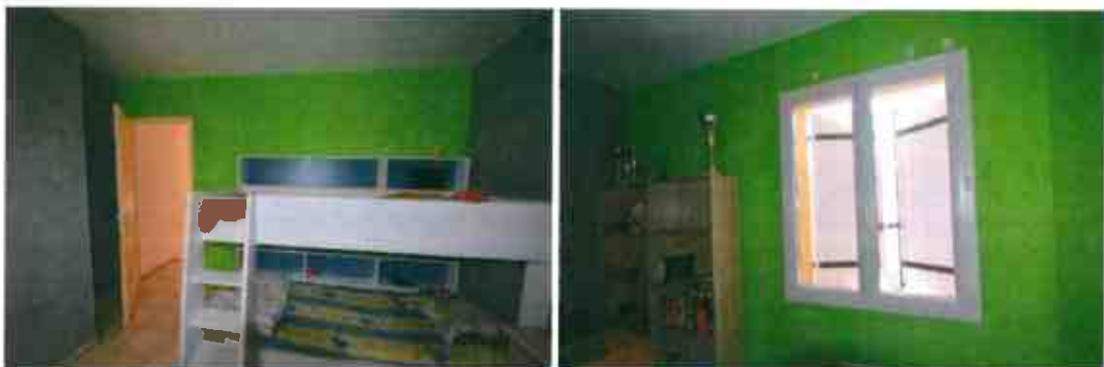
La pièce est ajourée par une fenêtre deux vantaux, côté ouest, châssis blanc, double vitrage, vitres intactes avec volets extérieurs en bois, état d'usage. Traces de dégoulinures sous la fenêtre.
